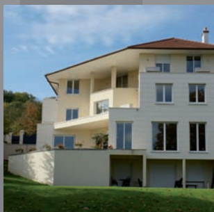
Résidentiel neuf : PAC+plancher chauffant/rafraîchissant, grand volume - IdF
