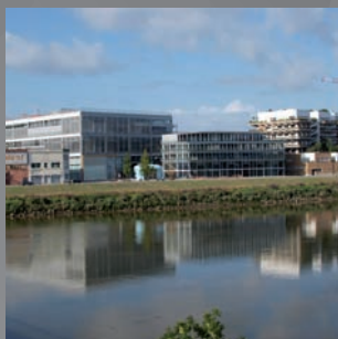
Tertiaire neuf : panneaux rayonnants dans 150 zones, bâtiment bioclimatique - 44
