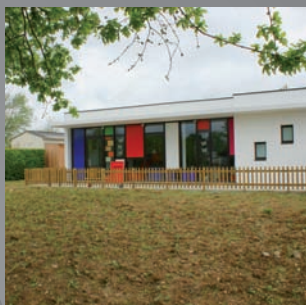
Tertiaire neuf : crèche HQE : solaire ecs, plancher chauffant, grandes baies vitrées - 44
