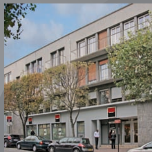
Logements collectifs + locaux commerciaux/rénovations : radiateurs, version 100% sans fil, gestion centralisée pr l'exploitant
