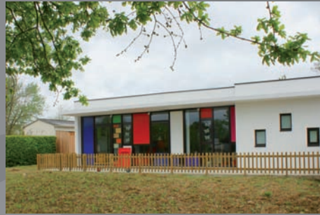
Neubau Öffentliches Gebäude: Kindergarten mit FBH / grosse Fensterflächen, Solar + WW-Heizung
