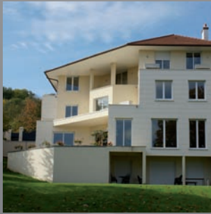
Neubau-Wohnhaus: FBH (Heizen/Kühlen) mit Wärmepumpe Grosse Volumen
