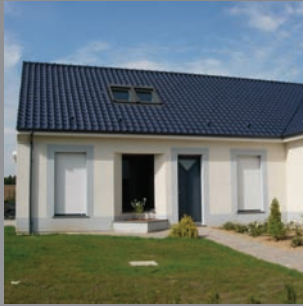
Neubau-Wohnhaus: FBH und Heizkörper mit Solarpanels
