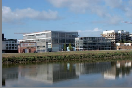
Neubau Öffentliches Gebäude: Architektur-Universität, 150 Zonen mit Deckenstrahlungsheizung
